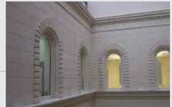
REVÊTEMENT DE FAÇADE, CORNICHE, ENTOURAGE D'OUVERTURE PLEIN CINTRE, BANDEAU INTERMÉDIAIRE EN PIERRE BLANCHE DE ST LOU
